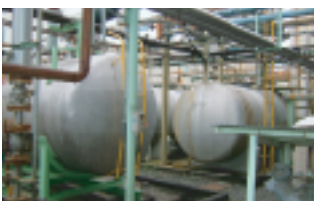
放爆槽（狭山サイト）
