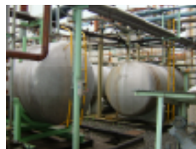
放爆槽（狭山サイト）
