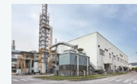
排気ガス処理設備
