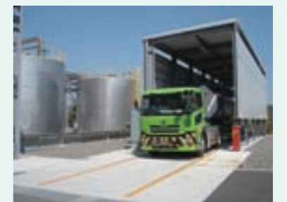
タンクローリー充填場
