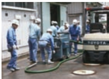
バックマンでの吸取り作業
