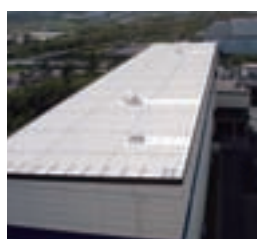
自動倉庫遮熱塗装
