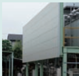
N棟東防音壁
