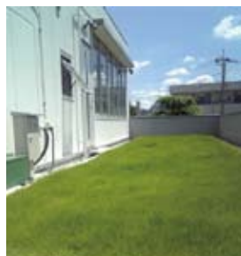
狭山事業所 事務棟屋上緑地化
