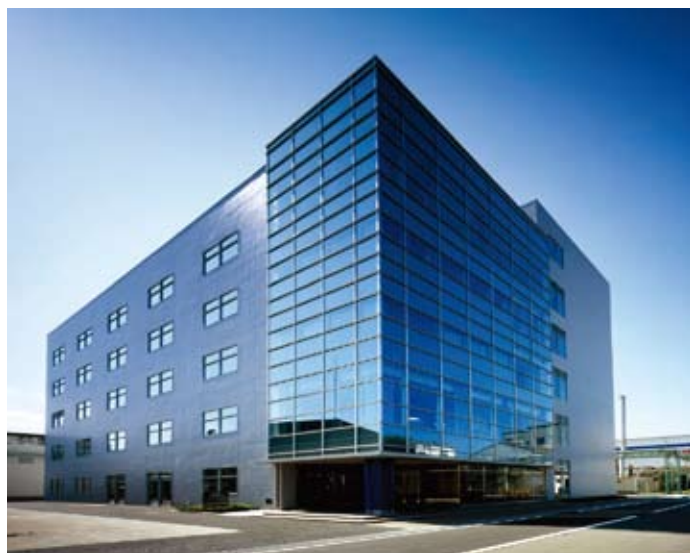
2006年完成した研究棟風景
