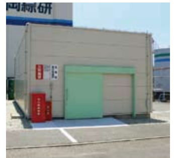
危険物5類倉庫
